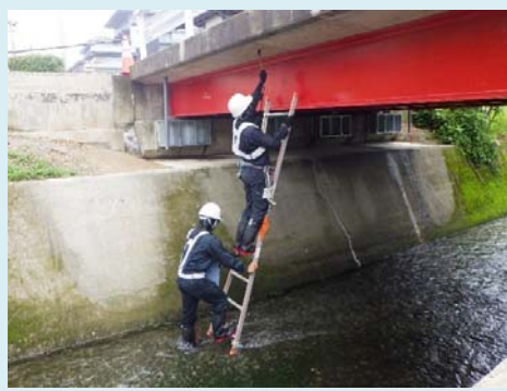
橋梁点検（梯子）
