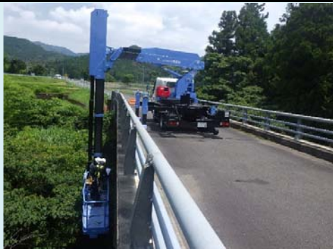
橋梁点検（橋梁点検車）
