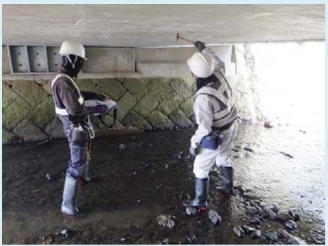
橋梁点検（地上）
