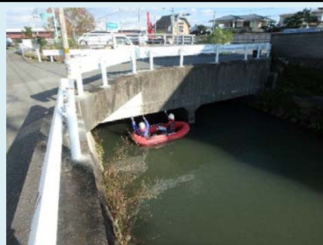
橋梁点検（船上）
