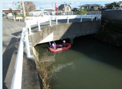
橋梁点検（船上）
