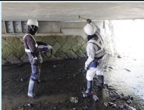
橋梁点検（地上）
