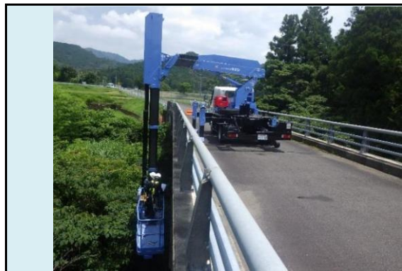
橋梁点検（橋梁点検車）
