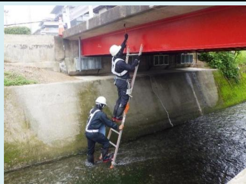
橋梁点検（梯子）
