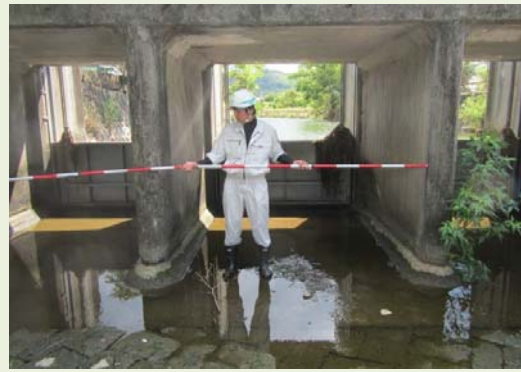
多々羅川 取水堰詳細設計業務(現地調査)
